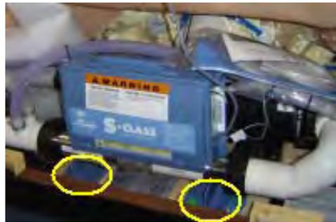
8. Si le spa est équipé d'une soupape de purge dans la zone du skimmer (voir figure à droite), retirez-la pour permettre à l'air de s'échapper de la ou des pompes pendant le remplissage du spa . Pour retirer la soupape de purge, dévissez-la jusqu'à ce qu'elle sorte sur toute sa longueur de la cloison du spa. Rangez les vis de purge dans un endroit sûr.
