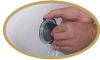
1. **Coupez l'alimentation électrique** au moyen de l'interrupteur différentiel et vidangez l'eau en dessous du niveau du luminaire.
